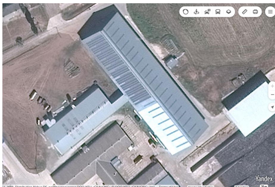
Рисунок 28 Спутниковый снимок фотоэлектрической системы на крыше мощностью 100 кВт в станции Старонижнестеблиевская в разгар строительных работ, 2019 г.
